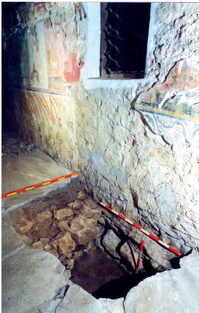
Обр. 5. Субструкция на разделителната стена между наоса и притвора на църквата „Св. Георги“
