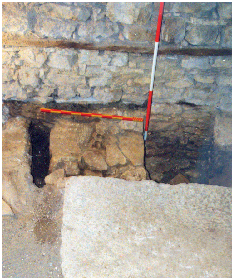
Обр. 11. Западна стена на притвора на църквата „Св. Георги“
